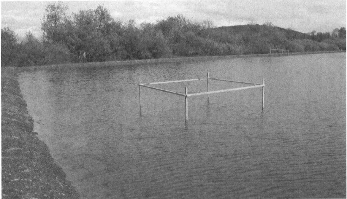
Abb. 1. Das Rohrkolbenfeld unmittelbar nach der Fertigstellung im Frühjahr 2007. (Foto R. Graf)
